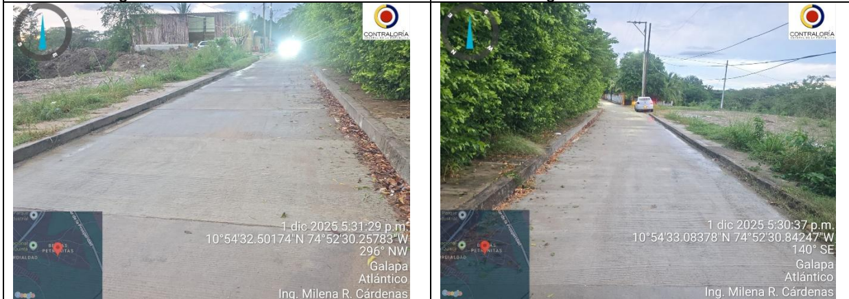
Condiciones generales de la vía
