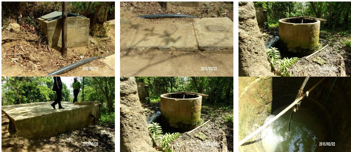
POZO PROFUNDO PROVEEDOR DE AGUA DULCE UBICADO EN EL SITIO DE MAYOR ALTURA
