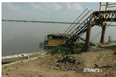
SITIO DE ADUCCION DE AGUAS CRUDAS PLATAFORMA DE BOMBAS EN RIO MAGDALENA
