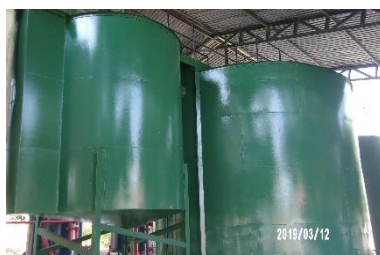
TANQUE ELEVADO PLANTA DE TRATAMIENTO DE SUMINISTRO DE AGUA
