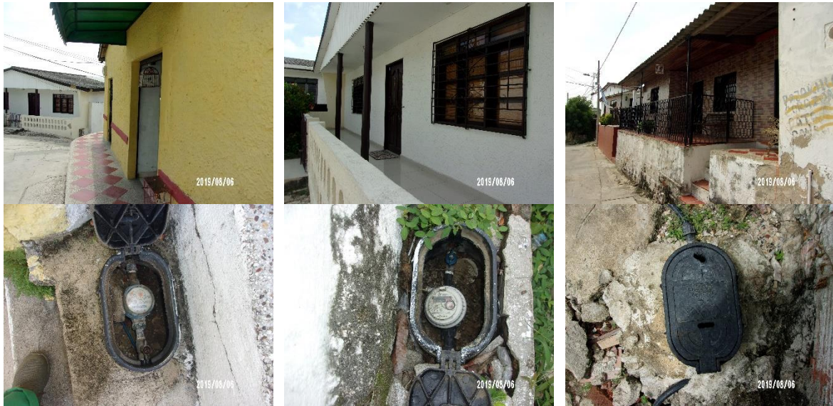
DOMICILIOS UBICADOS EN ZONA URBANA DOTADOS CON MEDIDORES PARA CONTROL DE CONSUMO
