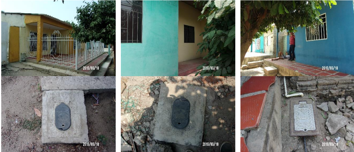
DOMICILIOS EN PONEDERA CON MEDIDORES DE VOLUMEN DE AGUA
