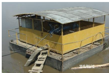
SITIO DE ADUCCION DE AGUAS CRUDAS PLATAFORMA DE BOMBAS EN RIO MAGDALENA
