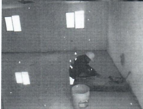
Acabos en estuco, tanto en el exterior como en el interior de la edificación. obras en desarrollo.
