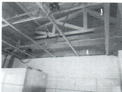
Instalación perfilaría metálica para cielo raso en yeso cartón.
